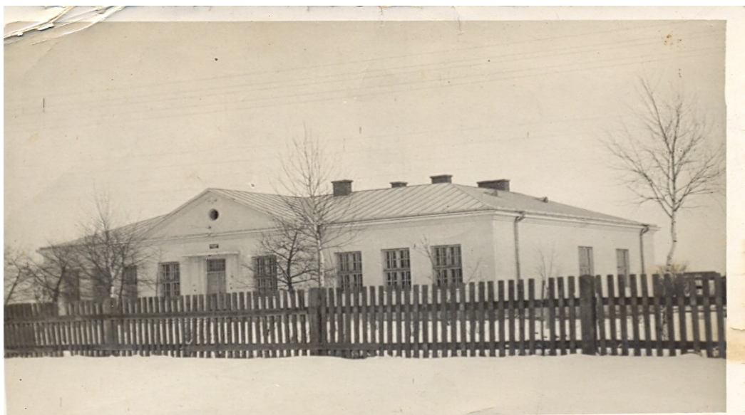
Fot.1 Pierwsze zdjęcie budynku szkoły
